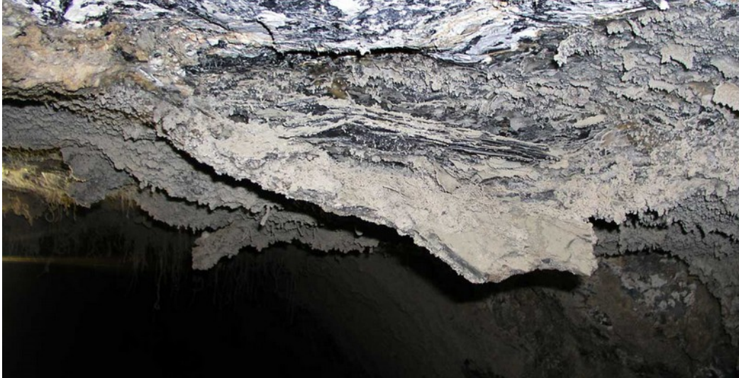
Figure 10. Plaquettes de calcaire en cours de décollement au plafond de la galerie.
